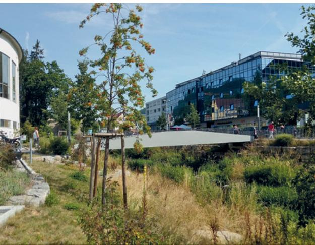
Brücke mit Carbonskelett: Diese Fußgängerbrücke in Albstadt ist eine der ersten Brücken mit Carbonbewehrung. Dadurch konnte sie sehr schlank und wartungsarm gebaut werden.
