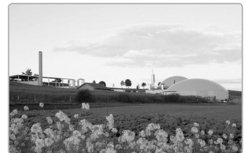
Biogasanlagen, wie die hier dargestellte einstufige Anlage in Jühnde erzeugen Methan für Elektrizitäts- und Wärmeerzeugung, sowie Kompost. Eine zweistufige Anlage nach dem IMK Verfahren könnte auch Klärschlämme verarbeiten und beispielsweise giftige Schwermetalle aus Klärschlämmen wieder auswaschen. Bildquelle: <http://www.bioenergie-dorf.info>
